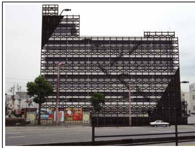
↓ビル足場イメージ
