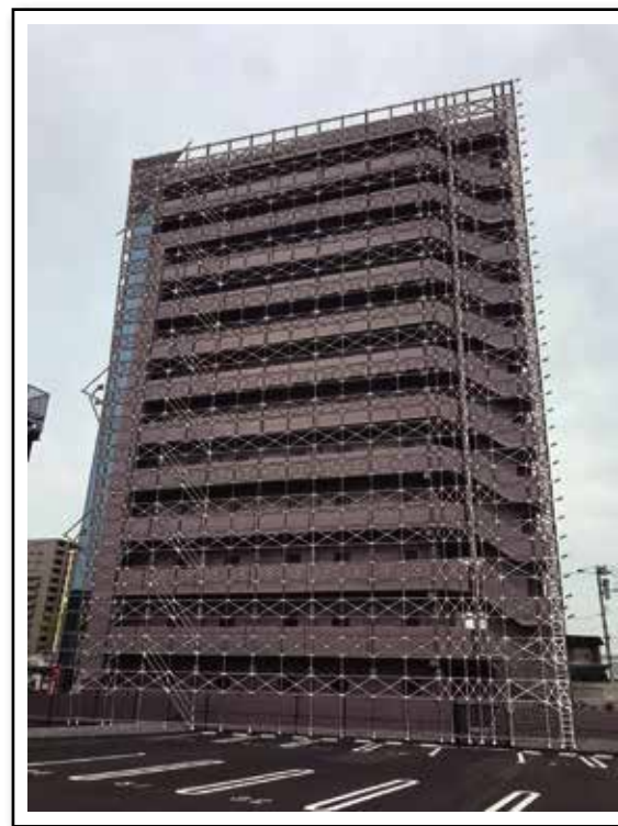
↓マンション足場イメージ
